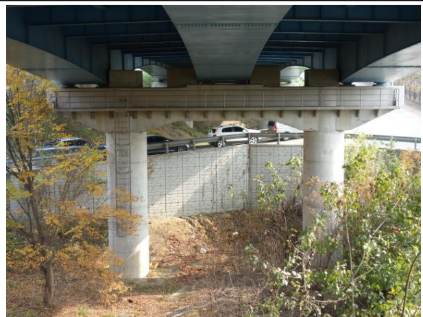
P4 교각 점검로 및 점검사다리 전경
