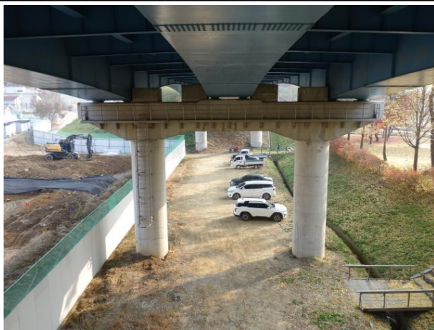
P2 교각 점검로 및 점검사다리 전경
