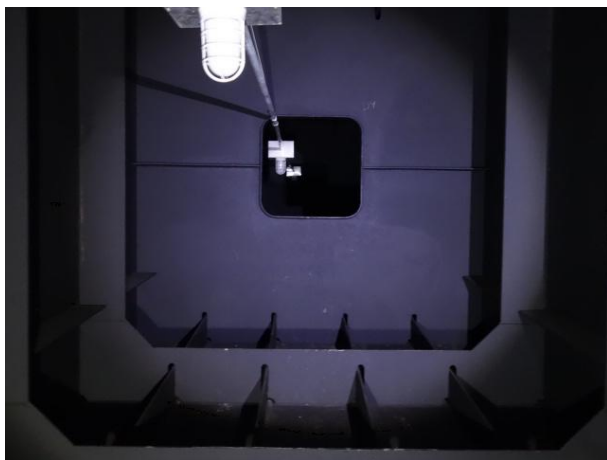
강박스 거더 내부 전경
