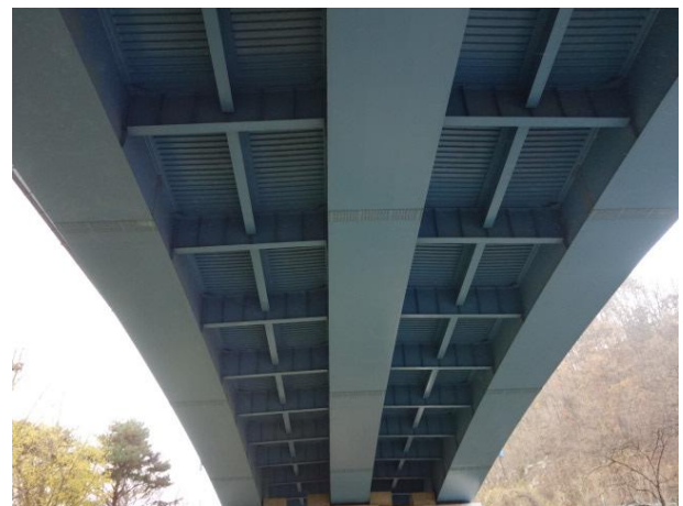
강박스 거더 외부 전경
